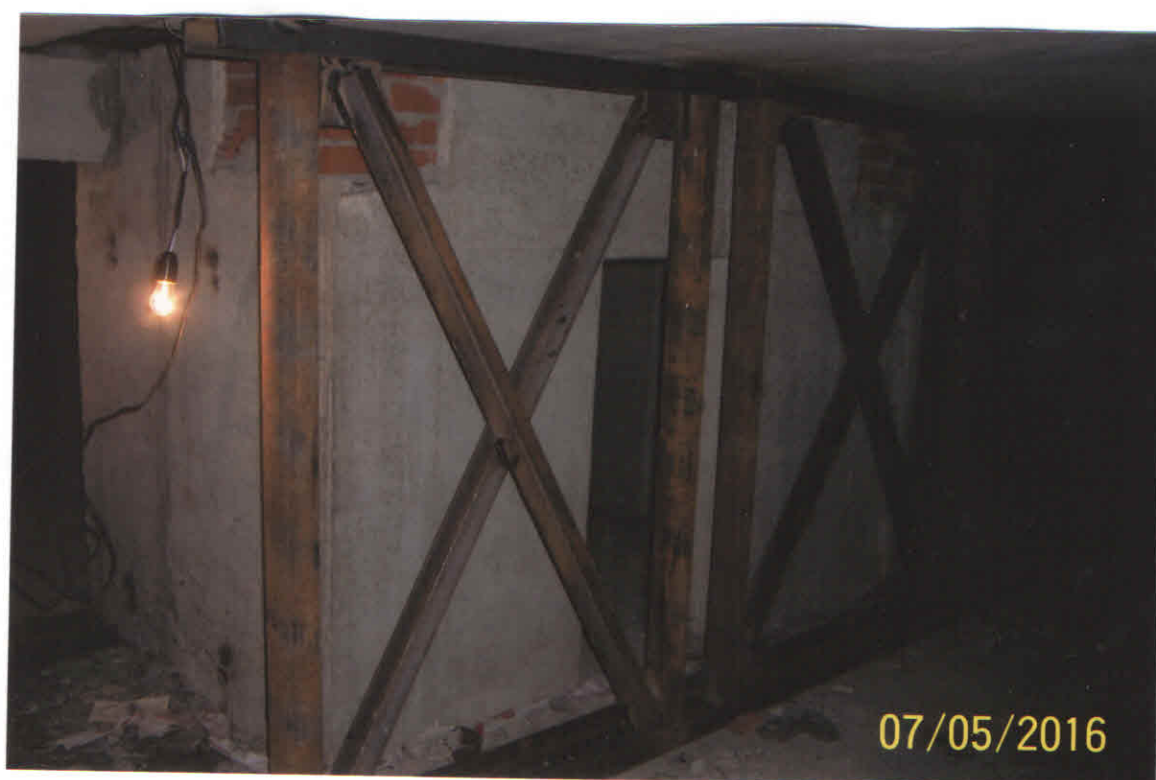
Фото 15. Временное усиление под плитами покрытия в месте отсутствия опорных площадок
