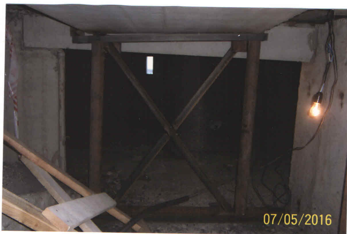
Фото 14. Временное усиление под «зависшей» плитой покрытия
