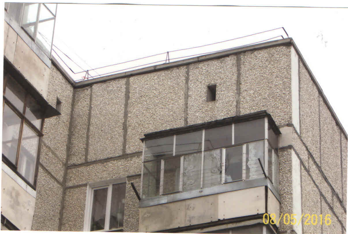
Фото 2. Общий вид по оси Гс
