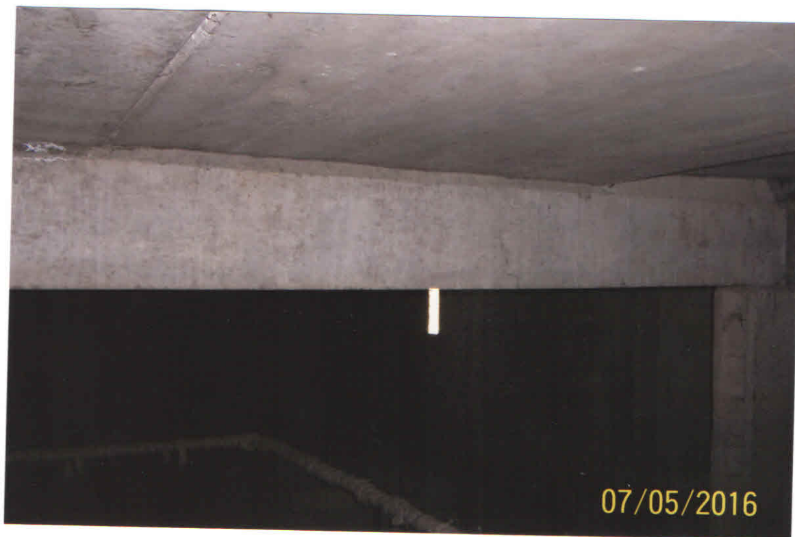
Фото 26. Балка покрытия по оси Дс
