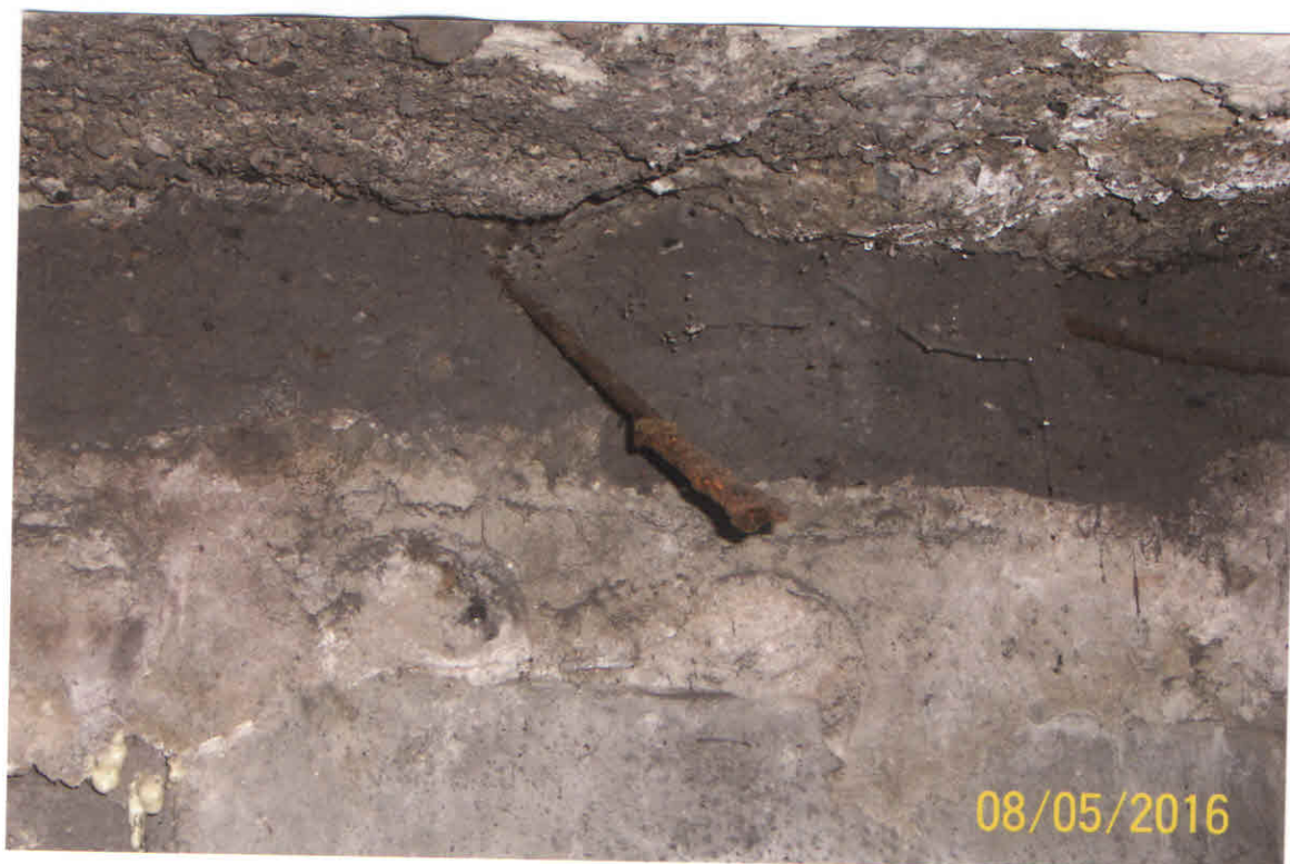
Фото 16. Сгнивший анкер парапетного блока
