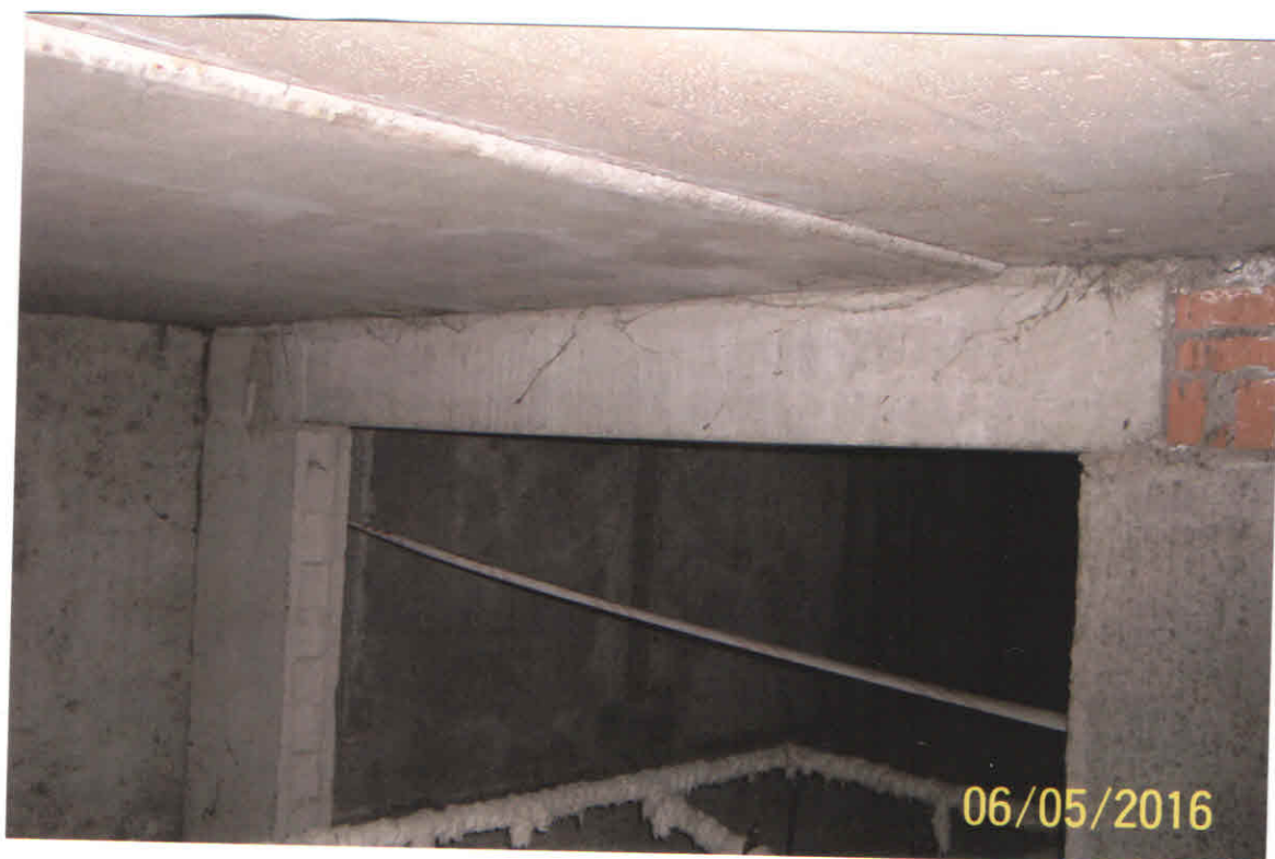
Фото 24. Балка покрытия по оси Вс
