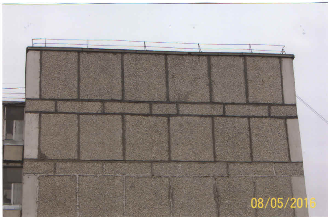
Фото 1. Общий вид по оси 1 в осях Гс - Дс
