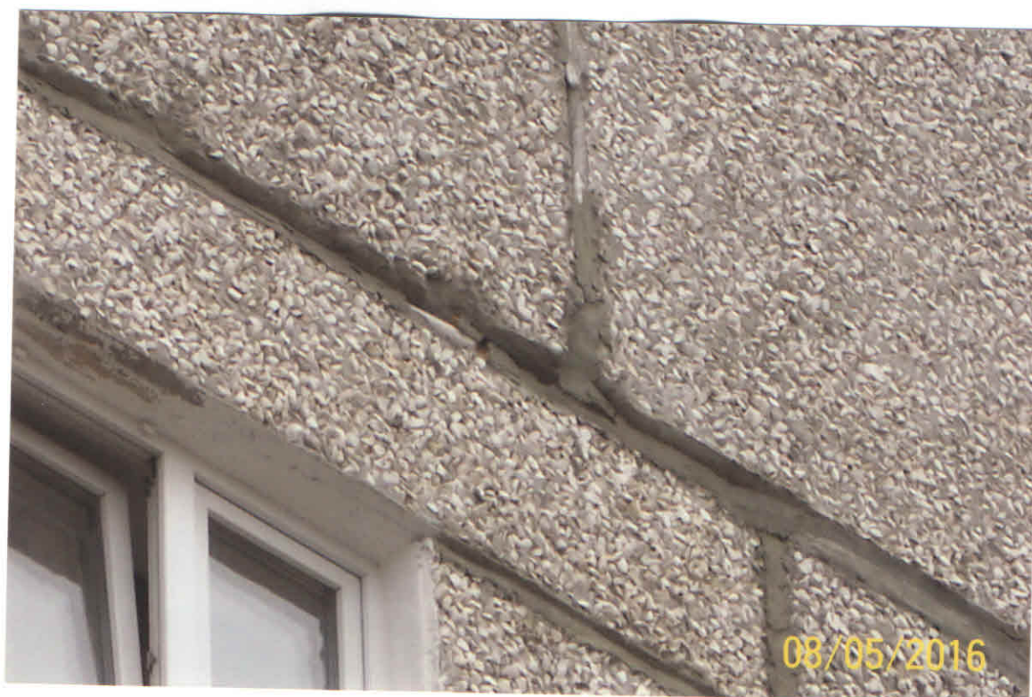
Фото 4. Фрагмент горизонтального шва по оси 2
